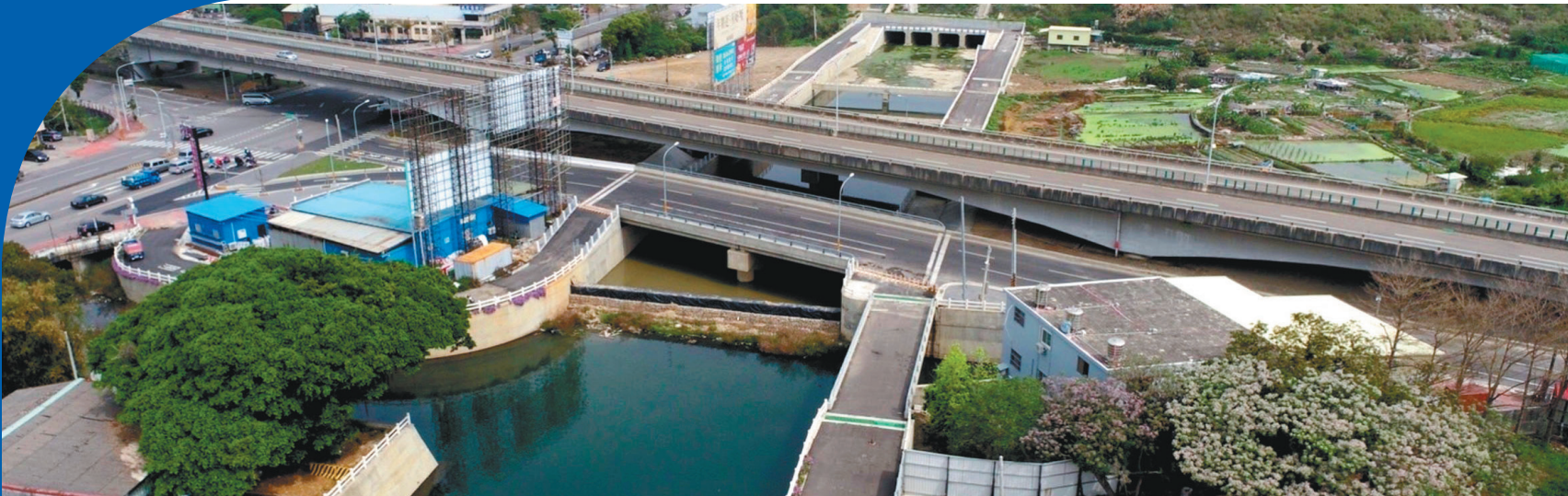
↑南山截水溝預計年底通水，將可解決海線地區積水問題，新闢的「向上一橋」與「向上二橋」可使向上路維持通行。圖中最靠近之橋梁為向上一橋。
