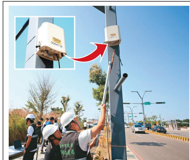
台中市環保局鎖定各大工業區布建511組「微型感測器」，感測器24小時全年無休，監測數據皆已上網公開。
