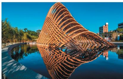
后里森林園區還有一件《籽仔：從天上掉下一顆種子》，利用自然素材創作，主體結構以台灣在地的孟宗竹及桂竹交錯組合而成，全手工打造，將數百根具有韌性的竹子彎曲組成，變成一座小秘境，15公尺高、直徑寬12公尺的巨型種子，呈現生命有機體的概念，抬頭仰望能看見交錯搖擺的
