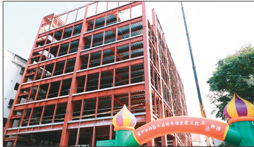
台中市政府9月再拿下4案停車場或前瞻預算補助，圖為西區大益停車場施工中。
