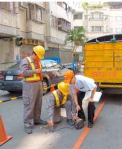
▲ 天然氣公司人員檢測馬路上埋設的天然氣管線。
