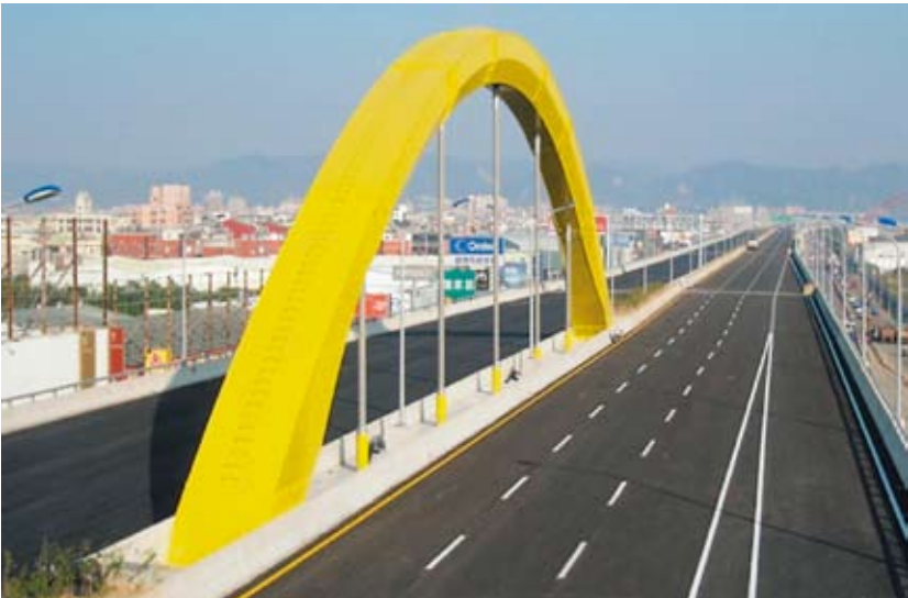
▲ 臺中生活圈2號線、4號線北段與平面道路延伸段、大里聯絡道開闢完成，縮短往返市區時程。
