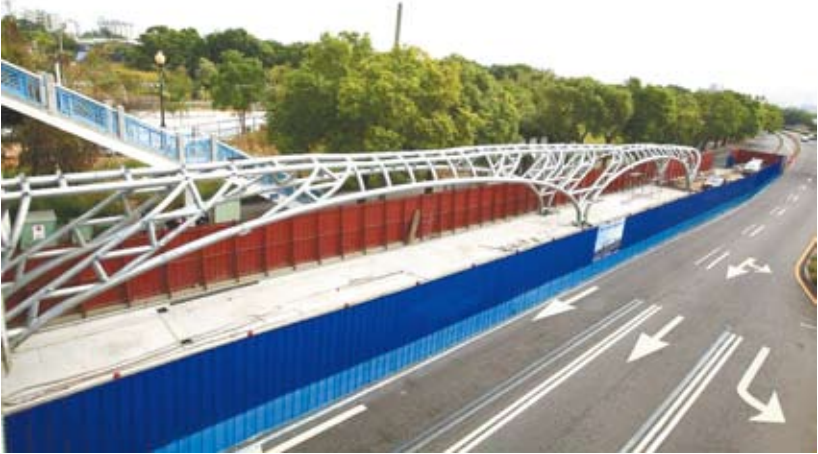
▲BRT東海大學國際街前的鋼構體，已在11月完工。
