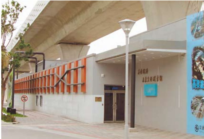
▲在北區興進路完工高架路段下方設的高架鐵路未來生活願景館，展示10座新站區3D模型供遊客參觀。
