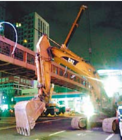
▲臺灣大道、文心路口的天橋已在上月拆除，臺中捷運綠線工程正式動起來。
