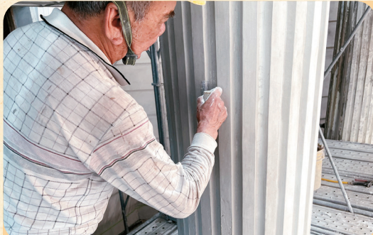
李昆山師傅手持特製模具，趁灰泥未乾前以均勻力道刮出平整圓弧
