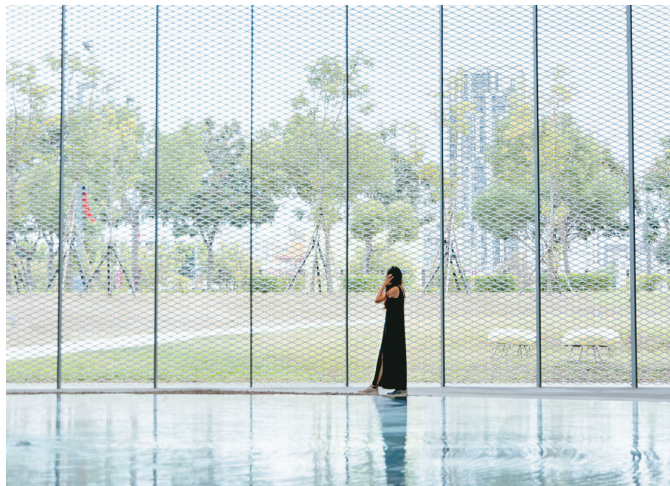
綠美圖大廳：四周由鋁製擴張網包覆，使綠意、風與光流入建築，連結自然與環境
